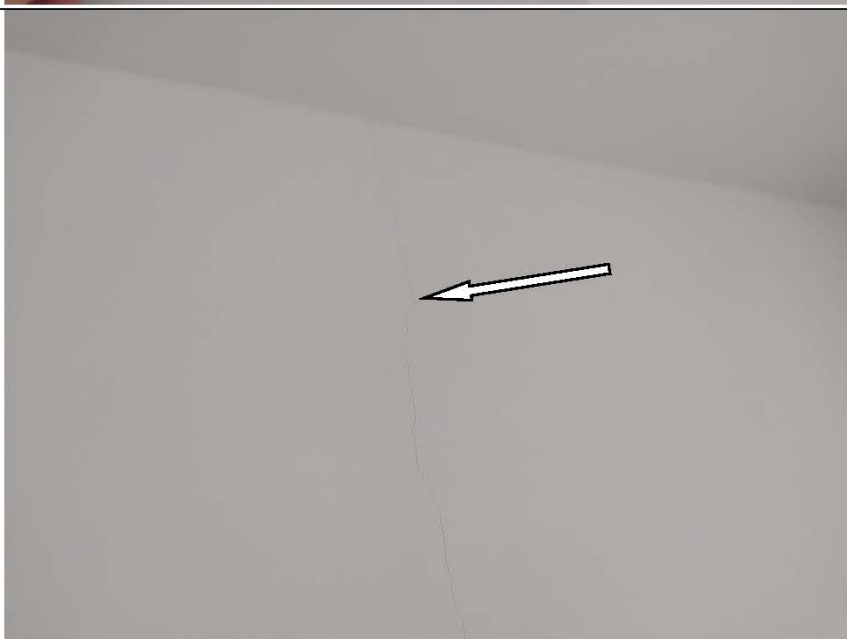
Фото №81. Шпаклеванные стены в кухне имеют дефекты (трещина).
