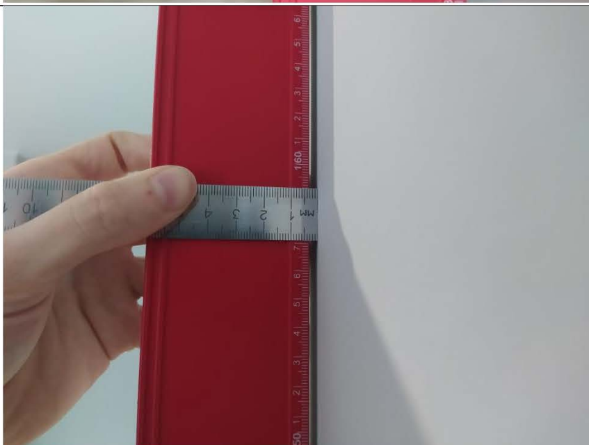
Фото №11. Измерение уровня стен в спальне.
