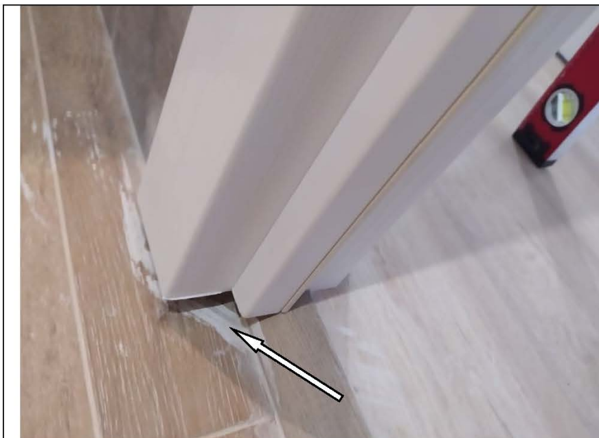
Фото №100. Загрязнение затирочным раствором напольной керамической плитки в санузле.
