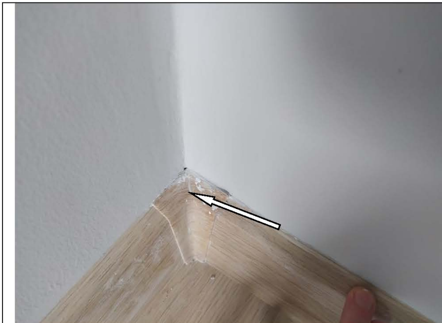
Фото №85. Загрязнение напольного плинтуса ПВХ в гостиной.
