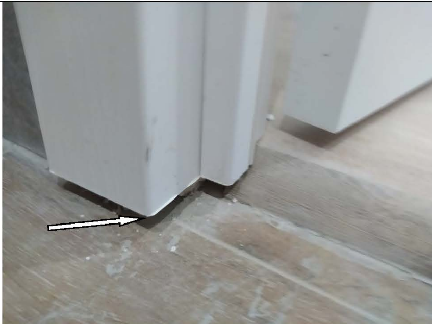
Фото №79. Наличник дверного блока в ванной комнате выполнен с дефектами (некорректная подрезка).
