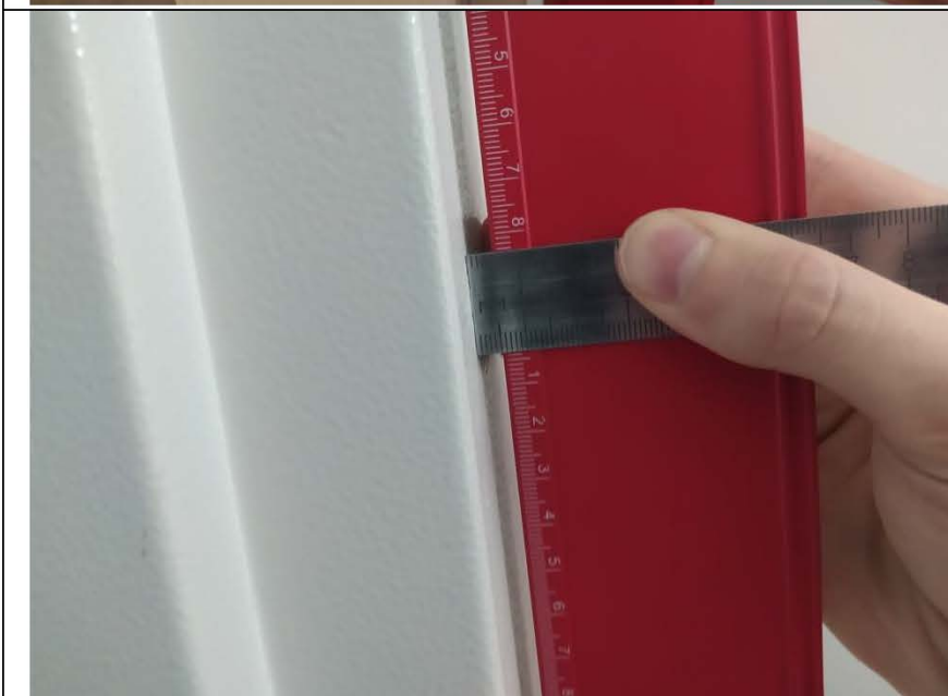
Фото №69. Отклонение коробки дверного входного блока.
