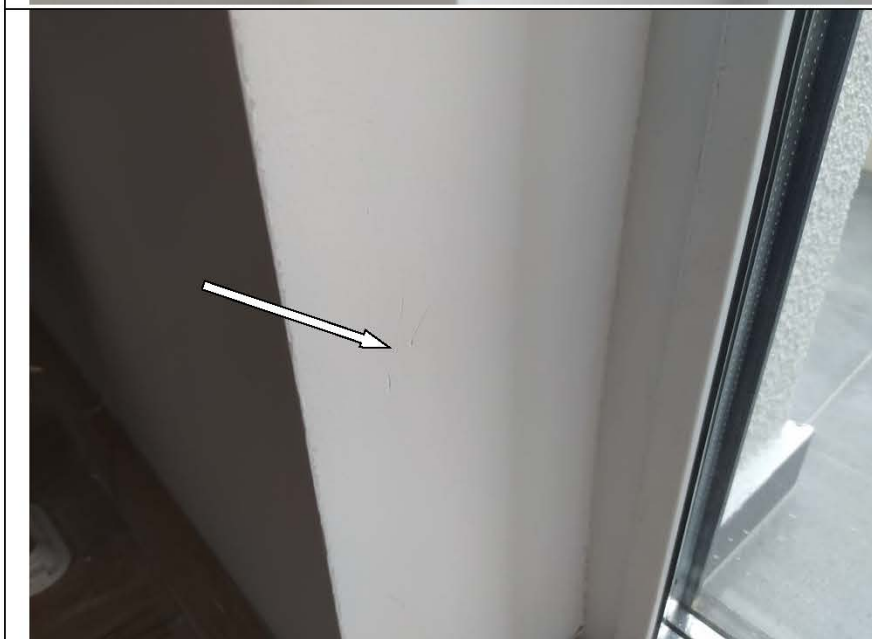
Фото №24. Глубокие царапины на окрашенной поверхности откосов дверного блока в спальне.
