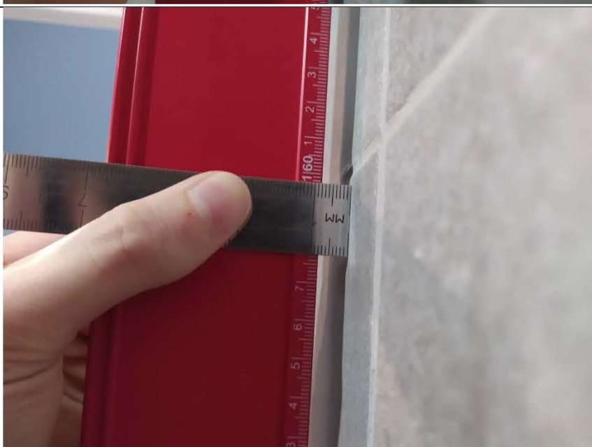
Фото №14. Измерение уровня стен в санузле.
