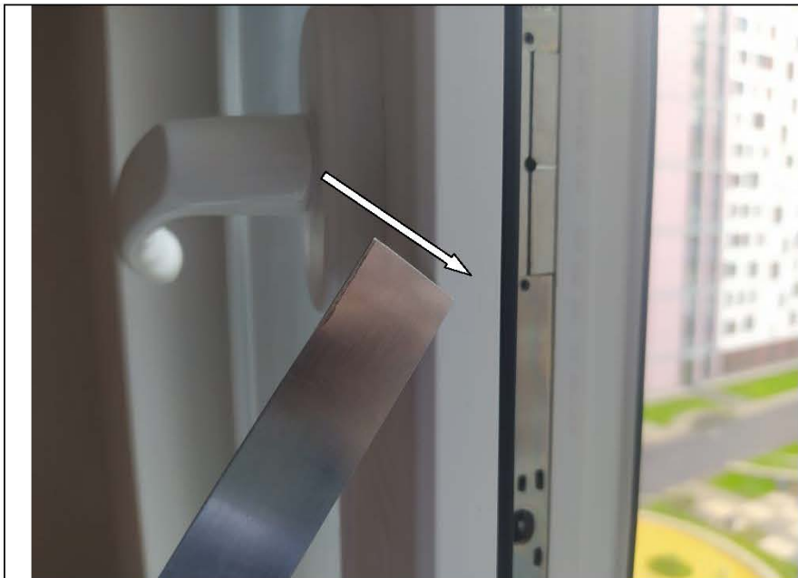
Фото №43. Профиль ПВХ оконного блока в детской имеет дефекты (царапина).
