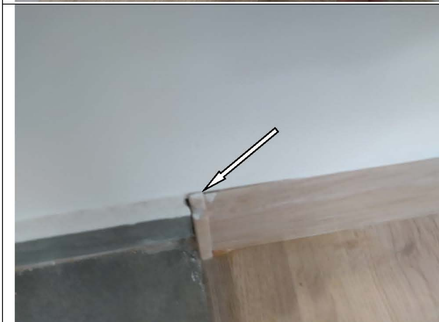
Фото №86. Загрязнение напольного плинтуса ПВХ в кухне
