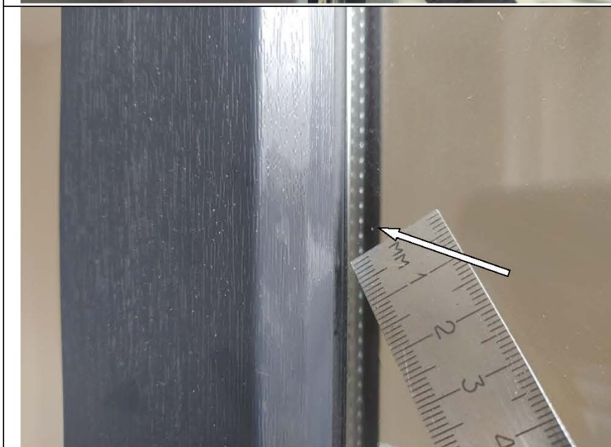
Фото №48. На стеклопакете оконного блока ПВХ в детской имеется дефект (окалина).
