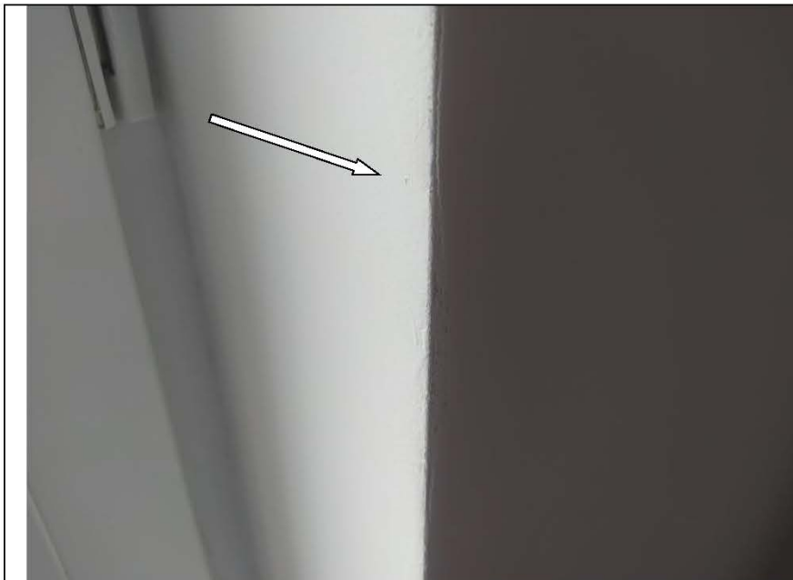
Фото №22. Неровность окрашенной поверхности откосов оконного блока в гостиной.
