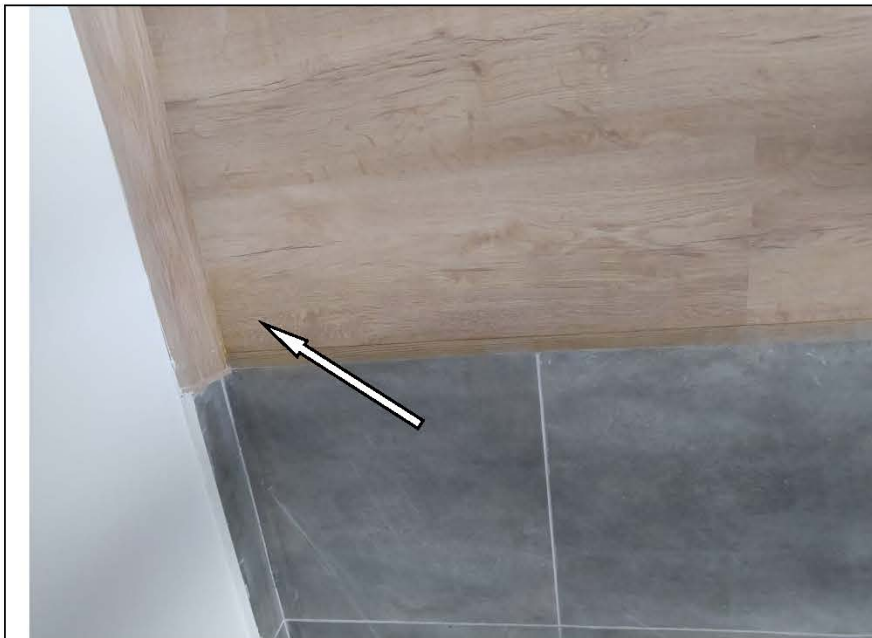
Фото №97. Загрязнения на поверхности ламината в кухне.
