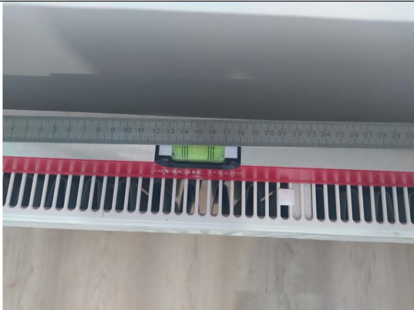
Фото №58. Отопительный прибор в детской смонтирован неровно.
