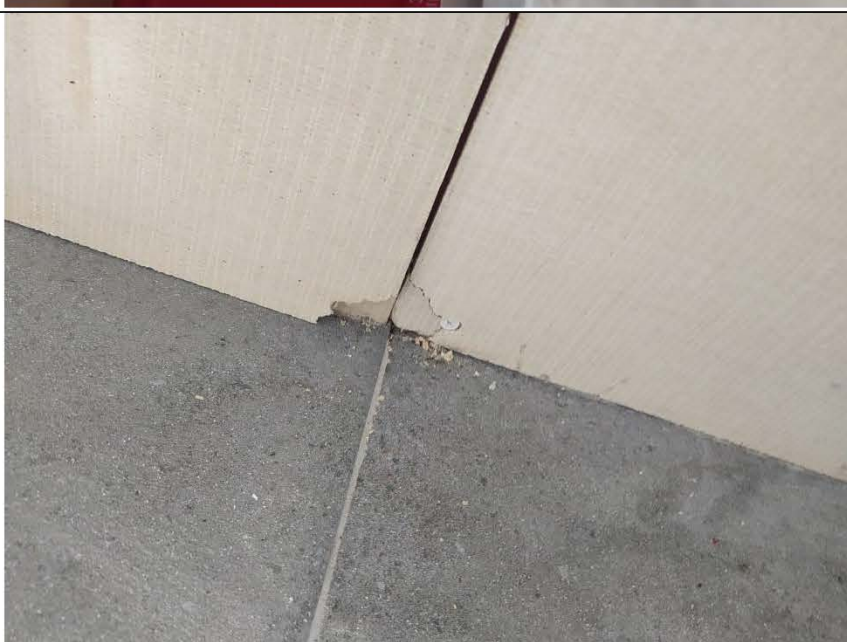
Фото №15. Сколы настенных панелей на балконе.
