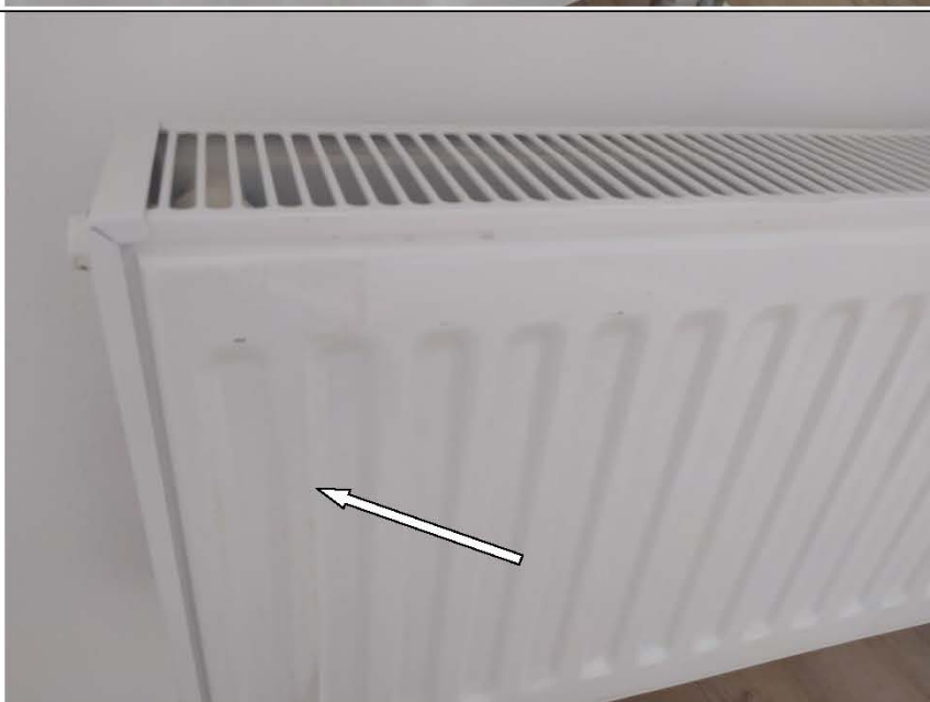
Фото №62. Радиатор №2 в кухне имеет дефекты (загрязнение клеевым составом от скотча).
