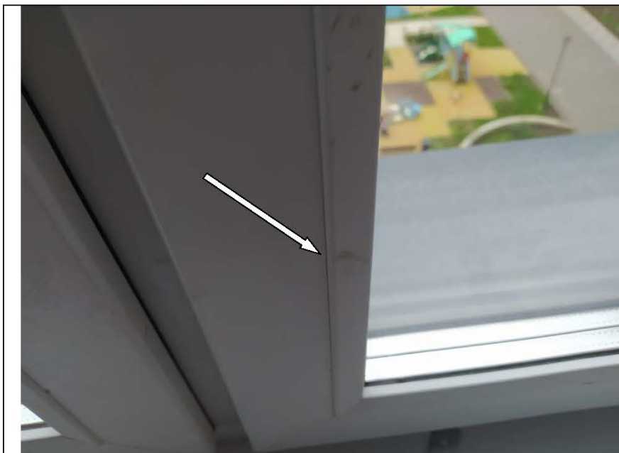
Фото №37. Профиль ПВХ оконного блока №2 в кухне имеет дефекты (загрязнения).
