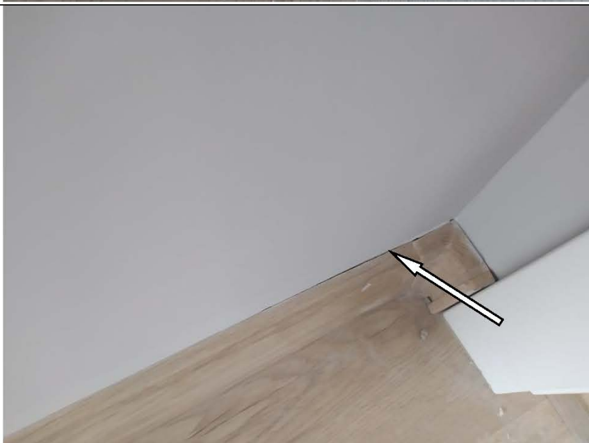
Фото №90. Напольный плинтус ПВХ в гостиной неплотно прилегает к стене (отходит), образуется зазор.
