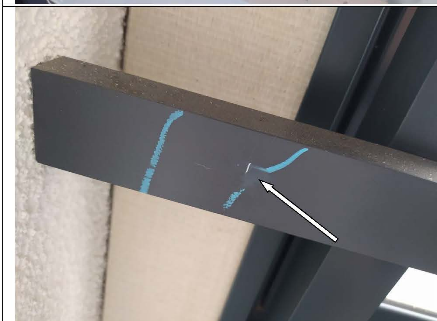
Фото №50. Дефект металлического профиля ограждения балкона (царапины).
