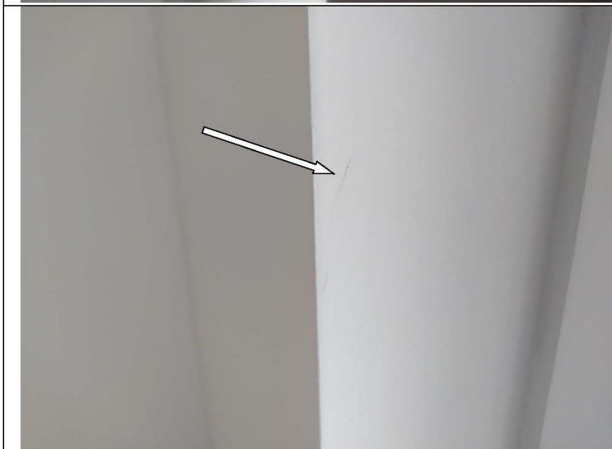
Фото №23. Следы от инструмента на окрашенной поверхности откосов оконного блока в кухне.
