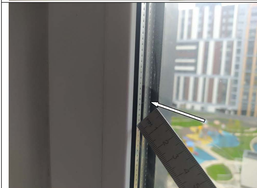
Фото №47. На стеклопакете оконного блока ПВХ в детской имеется дефект (царапина).
