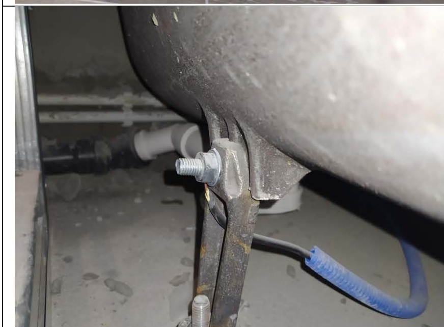
Фото №102. Частично отсутствует настенная и напольная керамическая плитка за ванной.
