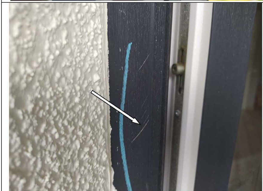
Фото №44. Профиль ПВХ дверного блока в спальне имеет дефекты (царапины).
