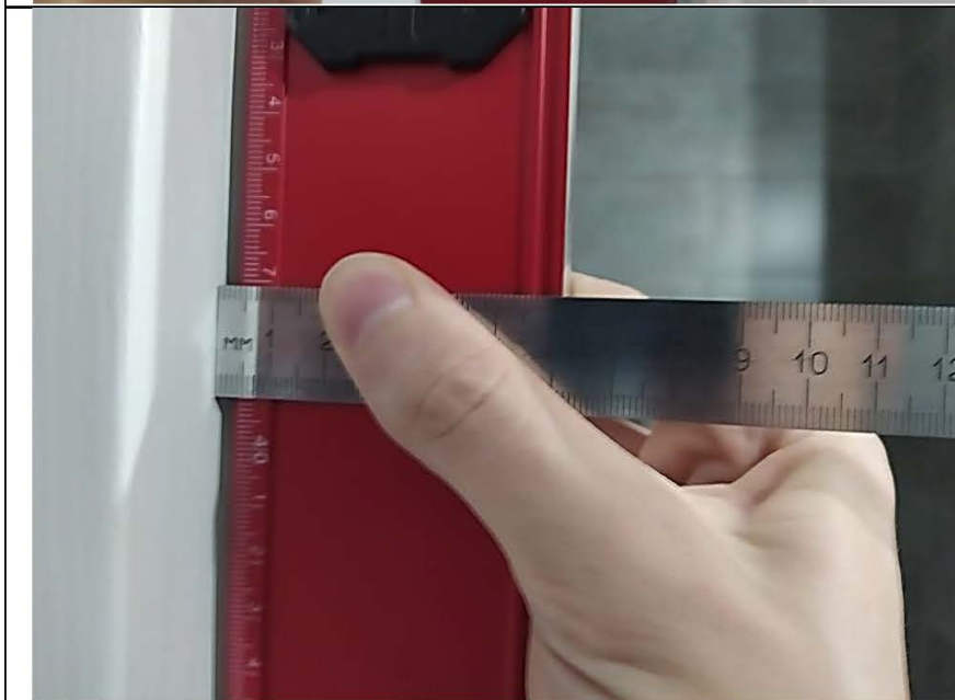
Фото №72. Отклонение наличников дверного блока в ванной комнате.
