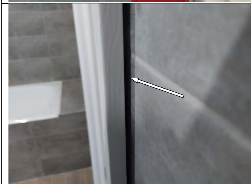
Фото №75. Неплотное прилегание дверного наличника к стене в ванной комнате.
