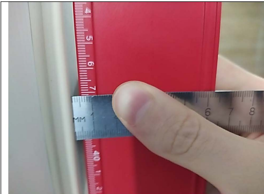
Фото №67. Отклонение коробки дверного блока в ванной комнате.
