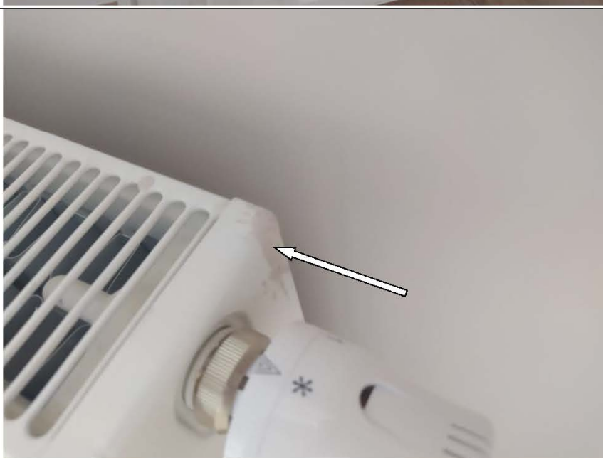
Фото №63. Радиатор в детской имеет дефекты (загрязнение малярными составами).
