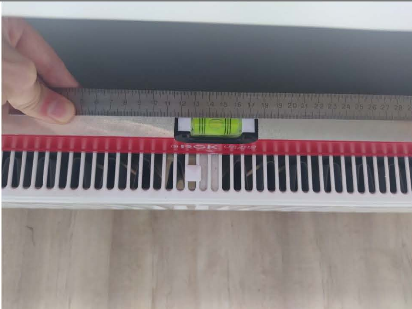
Фото №55. Отопительный прибор в гостиной смонтирован неровно.
