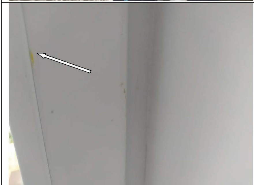
Фото №45. Профиль ПВХ оконного блока в детской имеет дефекты (загрязнения).
