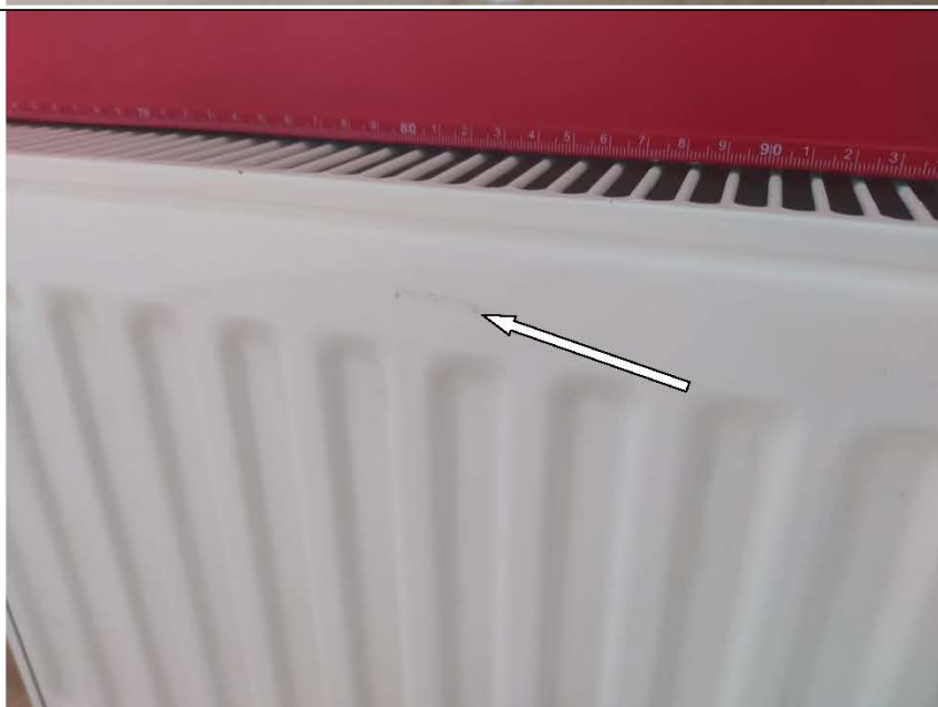
Фото №60. Радиатор №1 в кухне имеет дефекты (царапина).
