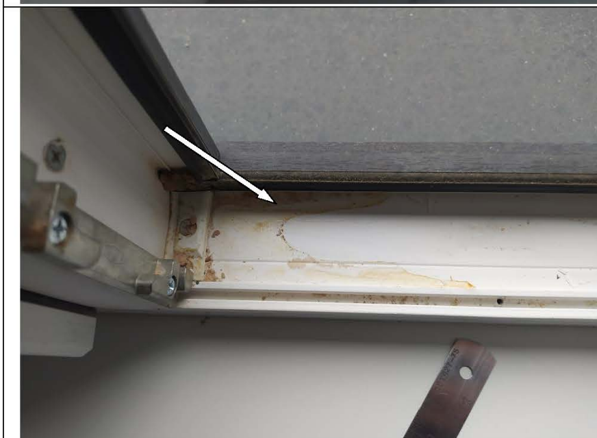
Фото №38. Откосы оконного блока ПВХ №2 в кухне имеют следы залития.
