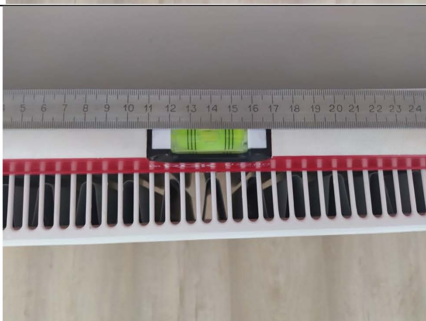
Фото №56. Отопительный прибор №1 в кухне смонтирован неровно.
