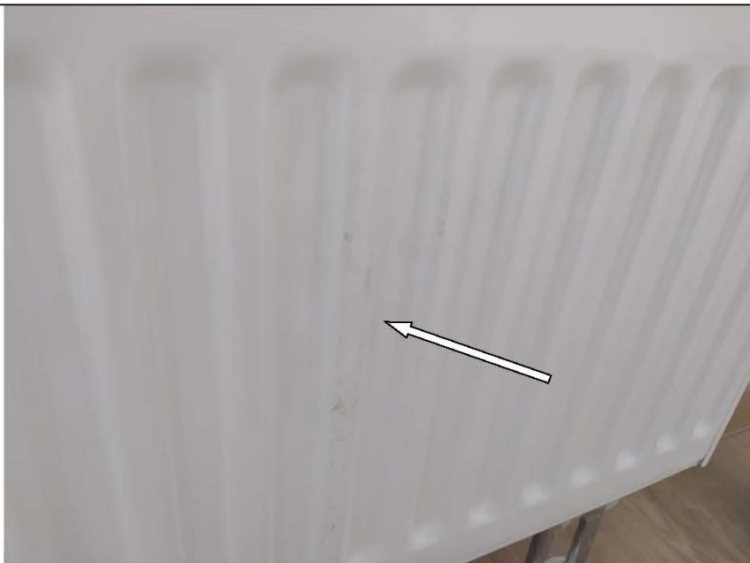
Фото №61. Радиатор №1 в кухне имеет дефекты (загрязнение клеевым составом от скотча).
