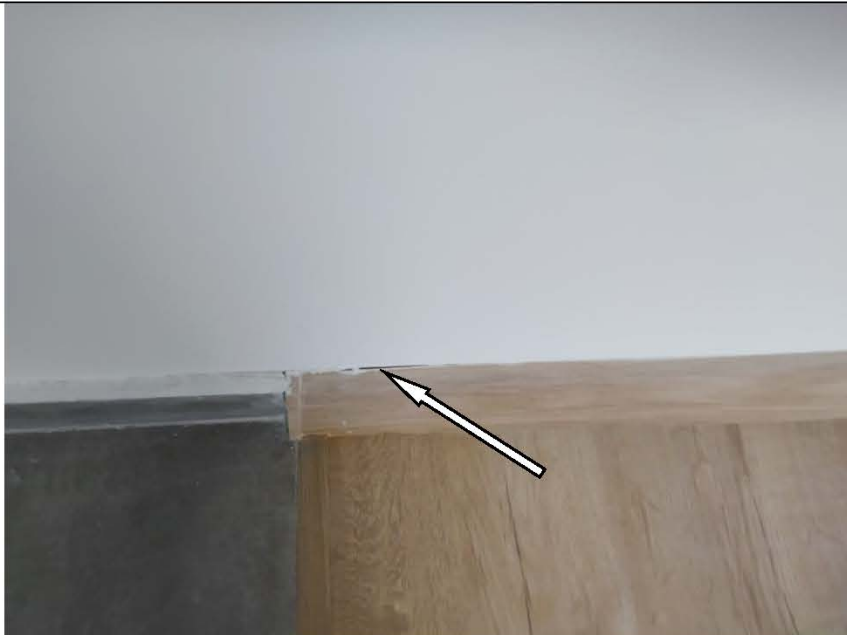
Фото №94. Напольный плинтус ПВХ в кухне неплотно прилегает к стене (отходит), образуется зазор.
