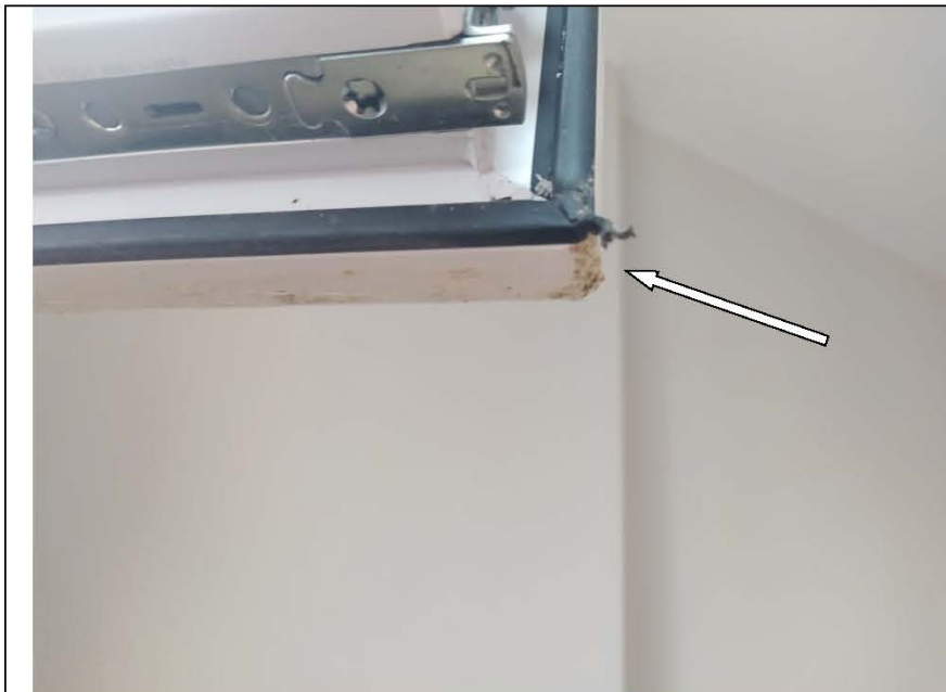
Фото №46. Дефект установки части уплотняющей прокладки на оконном блоке ПВХ в детской.
