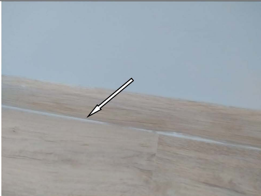
Фото №88. Загрязнение напольного плинтуса ПВХ в спальне.
