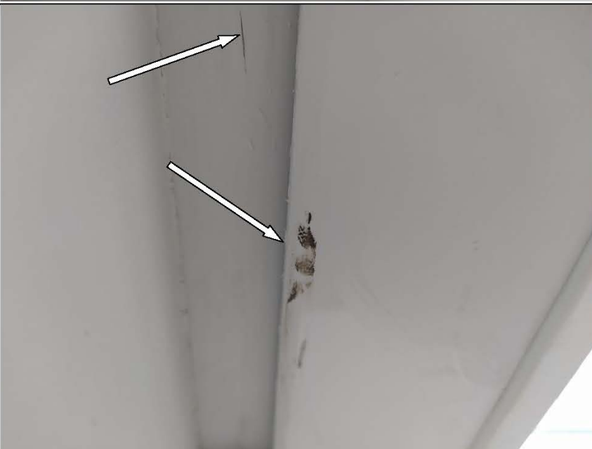
Фото №33. Профиль ПВХ оконного блока №1 в кухне имеет дефекты (царапина, загрязнение).
