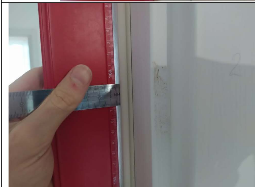
Фото №66. Отклонение коробки дверного блока в спальне.
