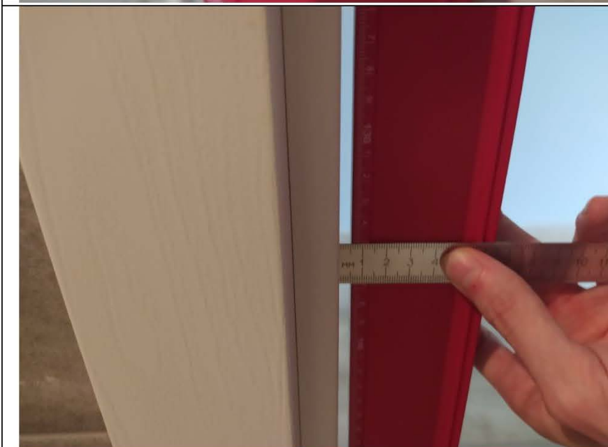
Фото №68. Отклонение коробки дверного блока в санузле.
