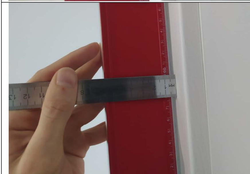
Фото №71. Отклонение наличников дверного блока в спальне.
