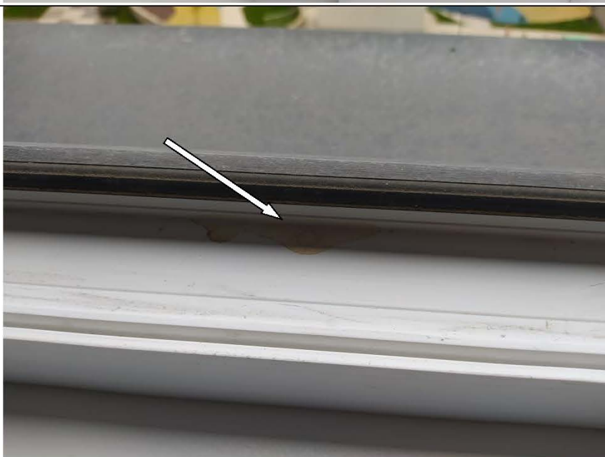
Фото №35. Откосы оконного блока ПВХ №1 в кухне имеют следы залития.
