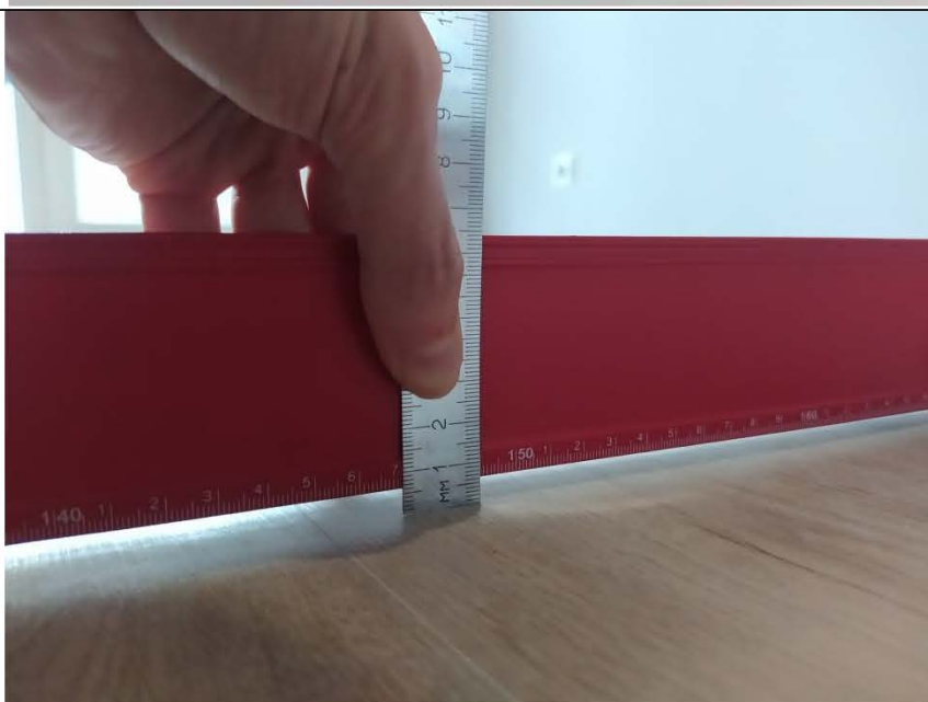
Фото №18. Измерение уровня напольного покрытия в спальне.
