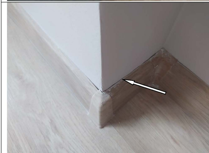
Фото №87. Загрязнение напольного плинтуса ПВХ в детской.
