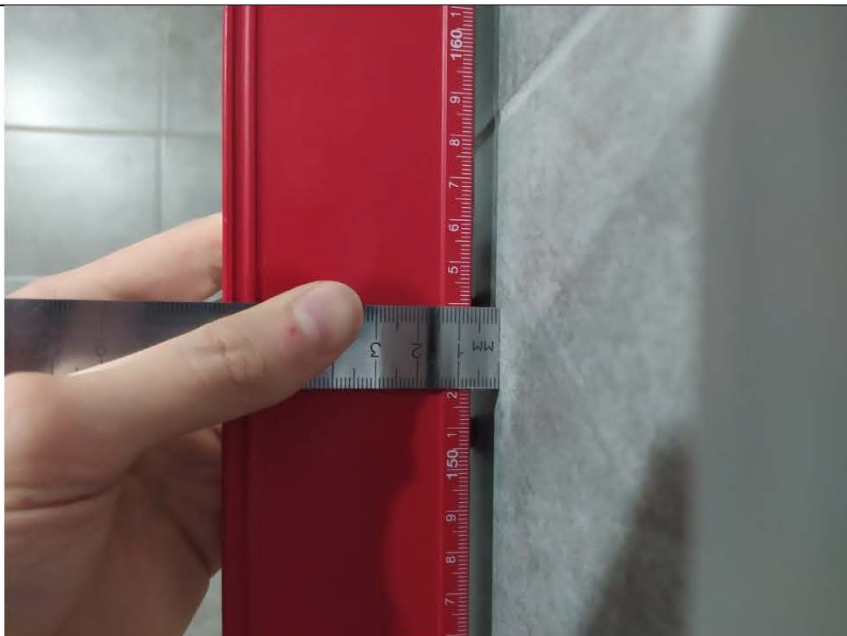
Фото №13. Измерение уровня стен в ванной комнате.
