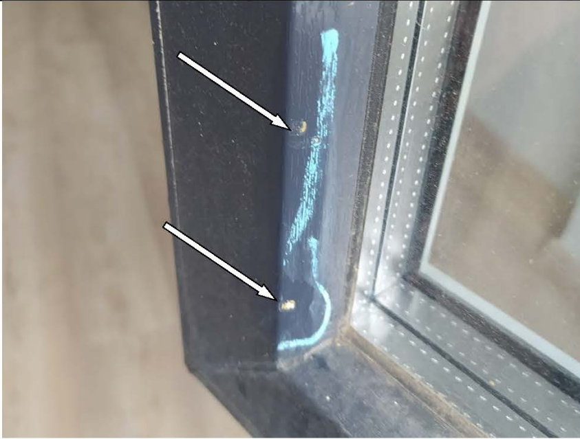
Фото №31. Профиль ПВХ оконного блока в гостиной имеет дефекты (окалины).
