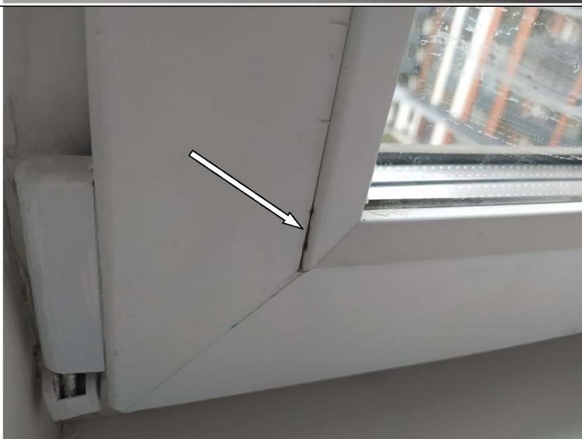
Фото №36. Профиль ПВХ оконного блока №2 в кухне имеет дефекты (щель в местах соединения элементов оконного блока).
