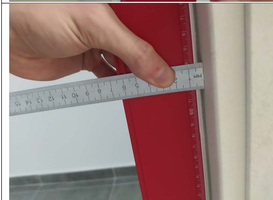
Фото №74. Отклонение наличников входного дверного блока.
