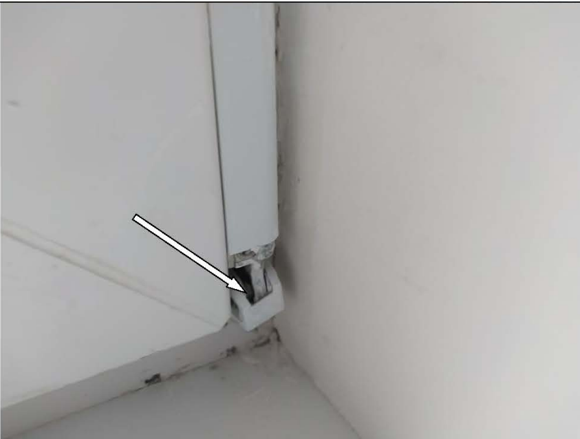
Фото №32. Дефект петли оконного блока ПВХ №1 на кухне (некачественный монтаж).
