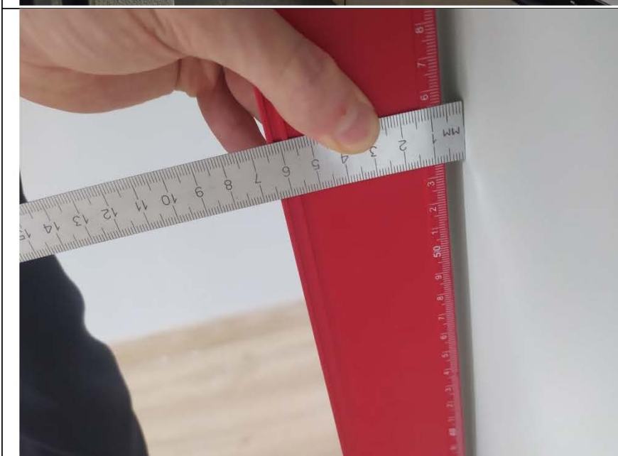
Фото №9. Измерение уровня стен в гостиной.
