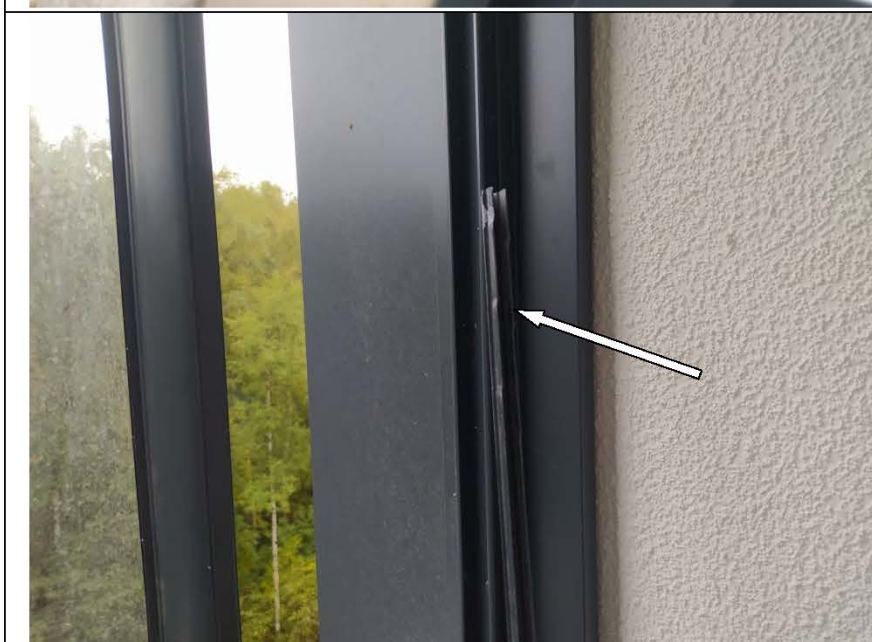
Фото №51. Нарушение целостности конструкции в связи с некачественным монтажом металлического профиля оконного блока на балконе.
