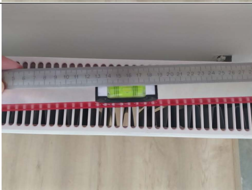
Фото №57. Отопительный прибор №2 в кухне смонтирован неровно.
