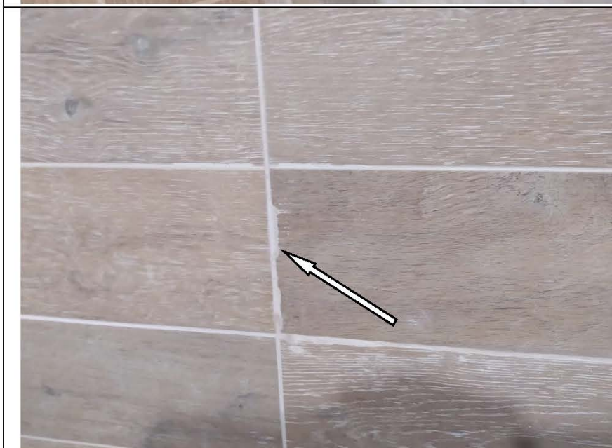
Фото №101. Загрязнение затирочным раствором напольной керамической плитки в ванной комнате.
